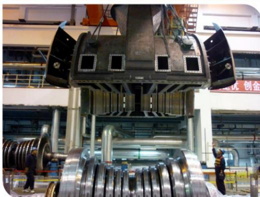
内蒙古上都发电有限责任公司3号机组为东方电气制造的600MW亚临界空冷机组，于2007年8月投入商业运行，该机组设计于上世纪90年代，与当前最新的通流设计技术存在代差，为响应国家节能减排政策并解决机组能耗较高的问题，电厂委托东方电气对3号机组实施通流部分提效节能改造。东方电气采用了调节级段气动优化、最新的叶型、高效3D叶片流道、边界层抽吸、末级叶片设计和优化、进排汽缸优化、先进汽封、密封结构优化、低压内缸结构优化等多项优化措施，对汽轮机实施了通流改造。
